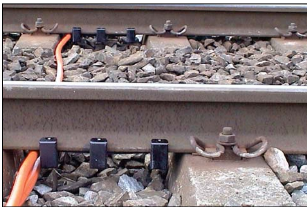
Slika 11. Postavljanje senzora na kolosek
